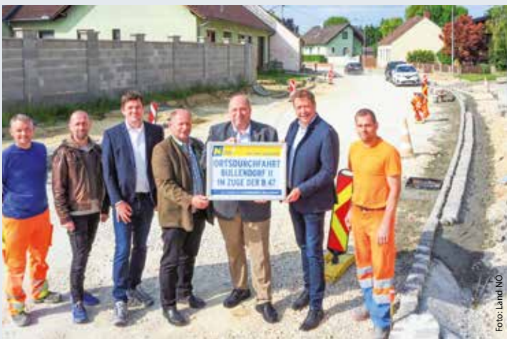
BR Michael Bernard, Bgm. Josef Tatzber und Leiter-Stv. der Straßenbauabteilung Wolkersdorf DDI Christian Schrenk-Lechner eröffnen den offiziellen Baubeginn der Arbeiten für den zweiten Bauabschnitt.
